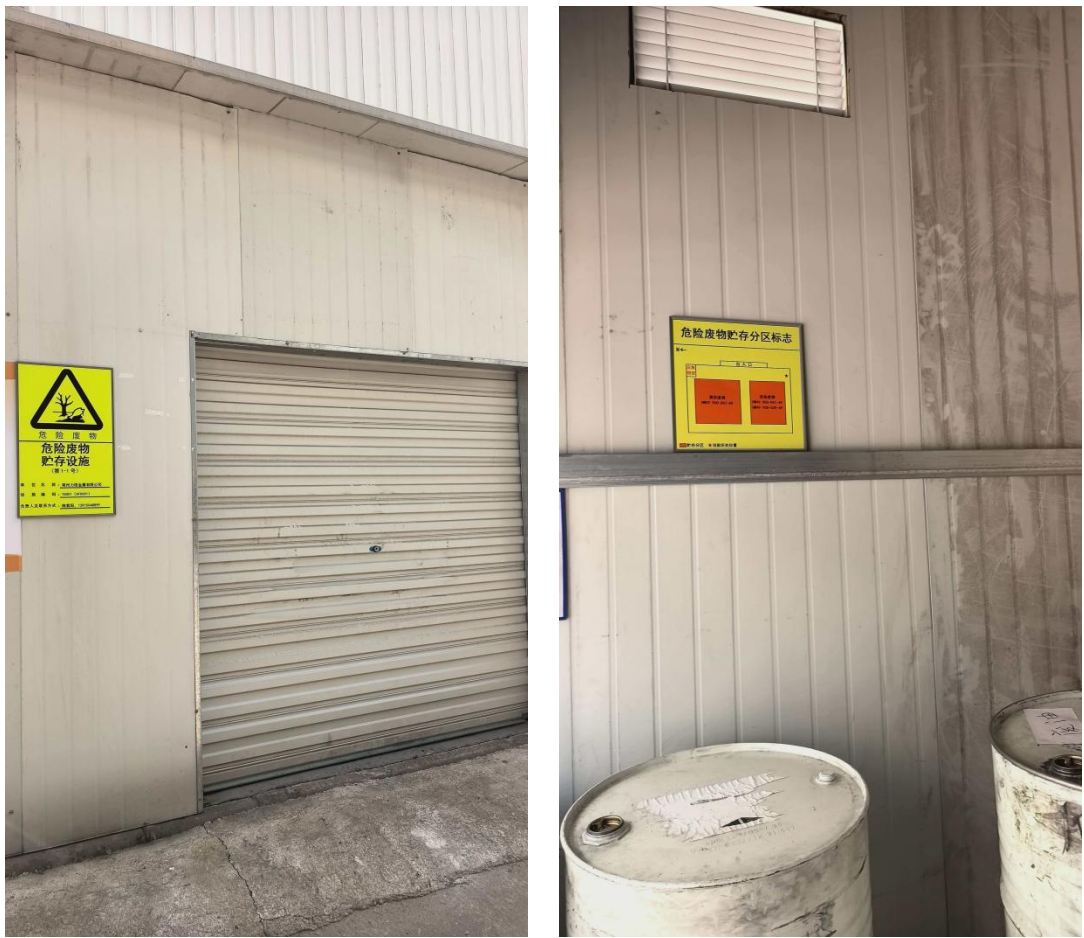
图 3-5 危废仓库储存情况
