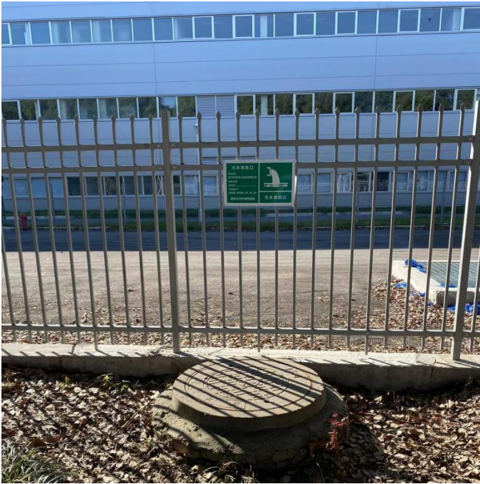
图 3-1 污水接管口（位于厂区门口）
