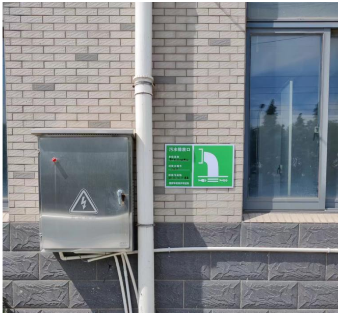
图 3-1 生活污水接管口 1 图（位于厂区门口）
